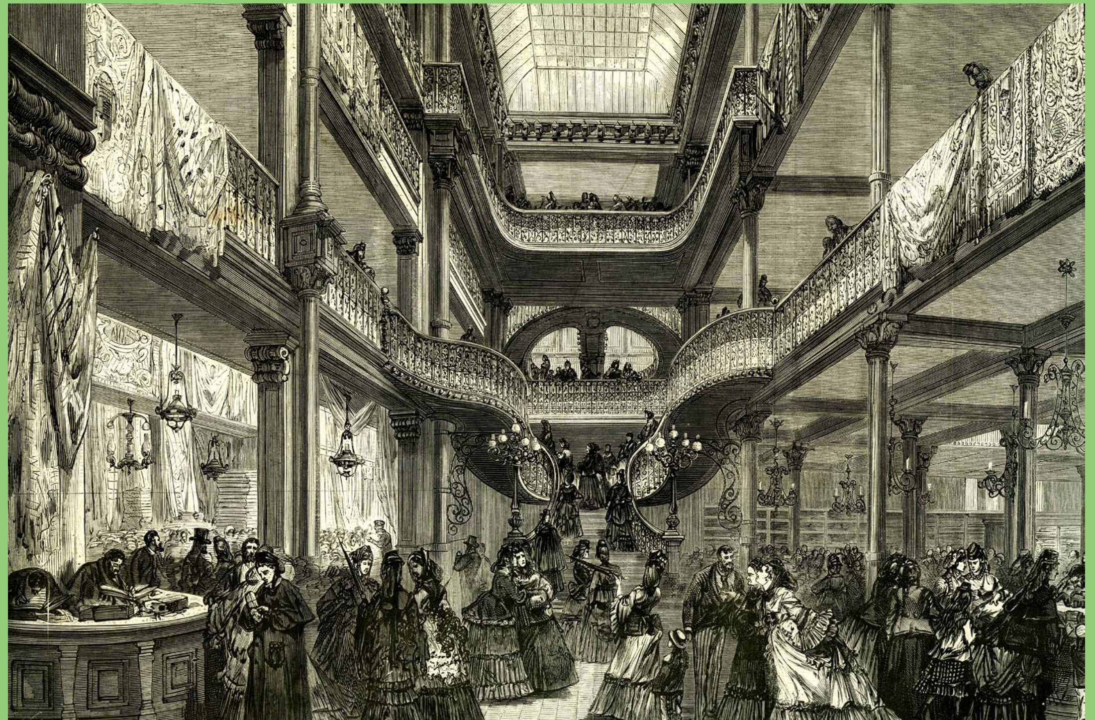
Le Bon Marché, Paris, 1872 mars 30 vue intérieure du Bon Marché, escalier principal – Source: © Le Monde Illustré; © Patrimoine Le Bon Marché Rive Gauche.
